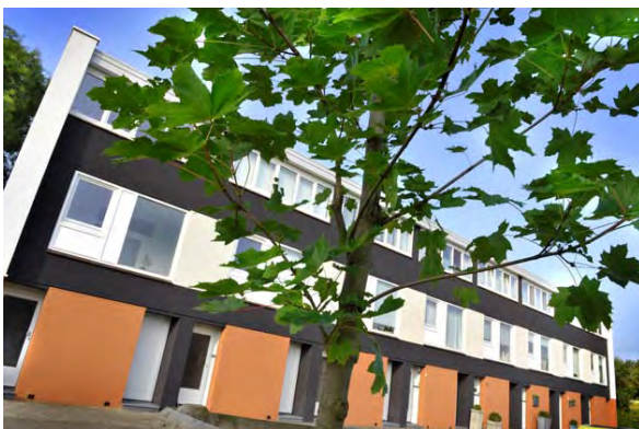
Teggert in Voerendaal na realisering van de eerste fase
